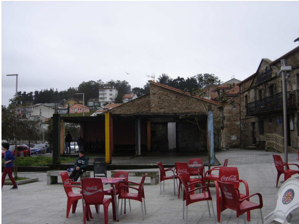
Estrutura da edificación con clave 061 a demoler para ampliar o L-096.
