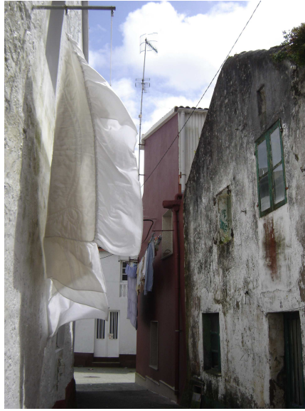
Casa mariñeira onde o muro piñón configúrase en fachada.
